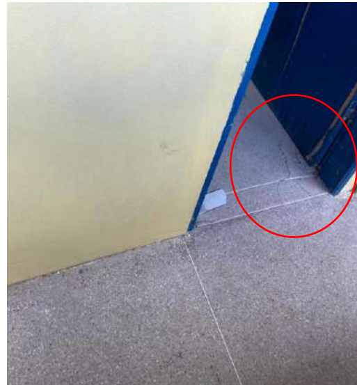
Fotos 4 e 5 – Rachaduras no piso.
