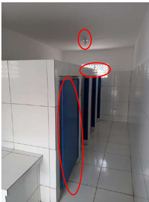
Fotos 23 e 24 – Banheiros.
