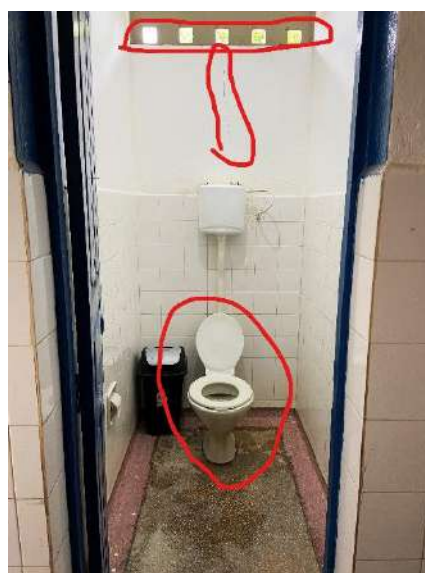
Fotos 4 e 5 – Banheiros.
