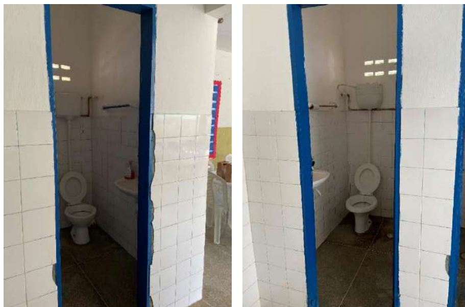
Fotos 8 e 9 – Banheiros.
