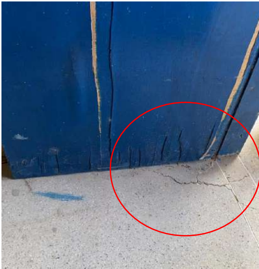
Fotos 4 e 5 – Rachaduras no piso.
