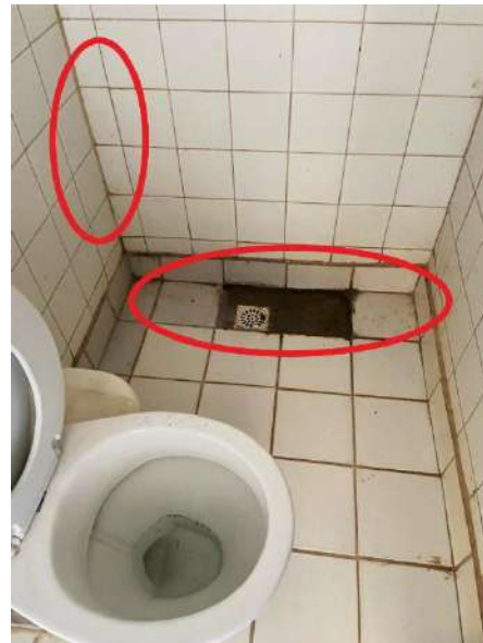
Fotos 18 e 19 – Banheiros.
