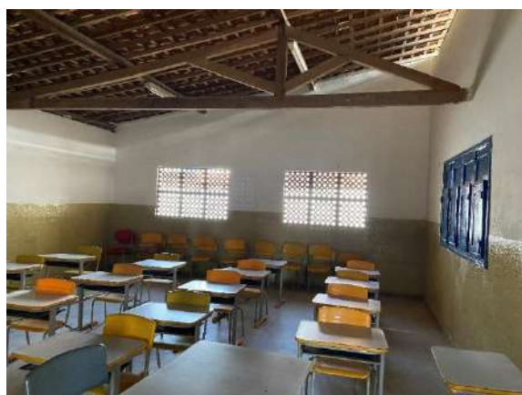
Foto 4 – Sala de aula.
