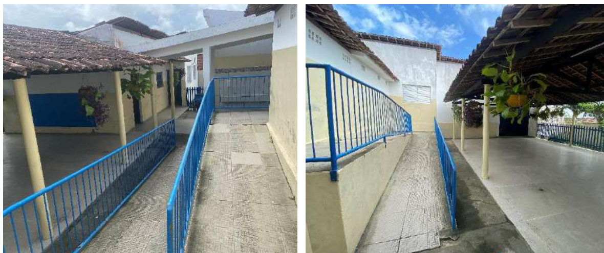
Fotos 4 e 5 – Área externa.
