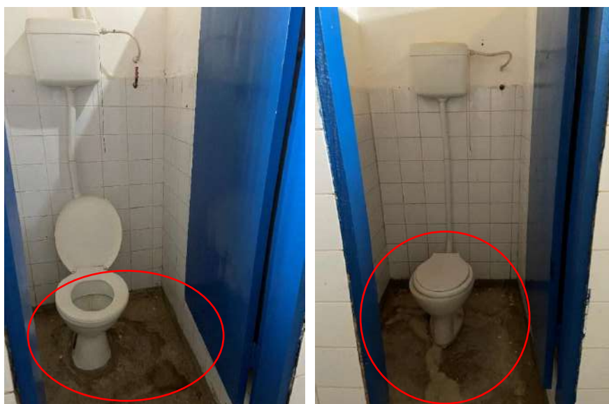
Fotos 7 e 8 – Banheiros.
