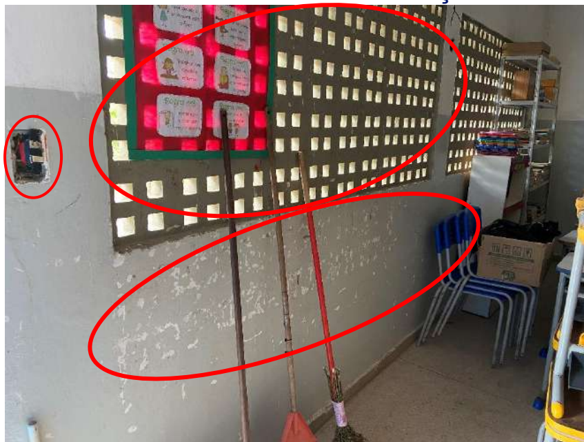
Foto 16 – Sala de aula.
