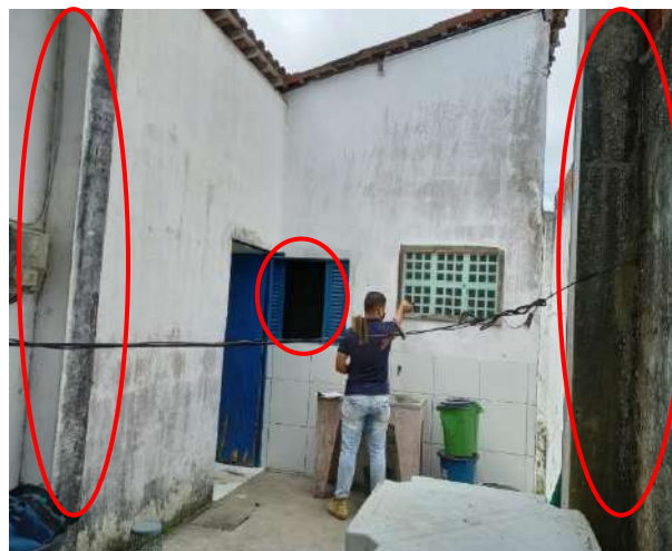
Foto 36 – Área de Serviço.
