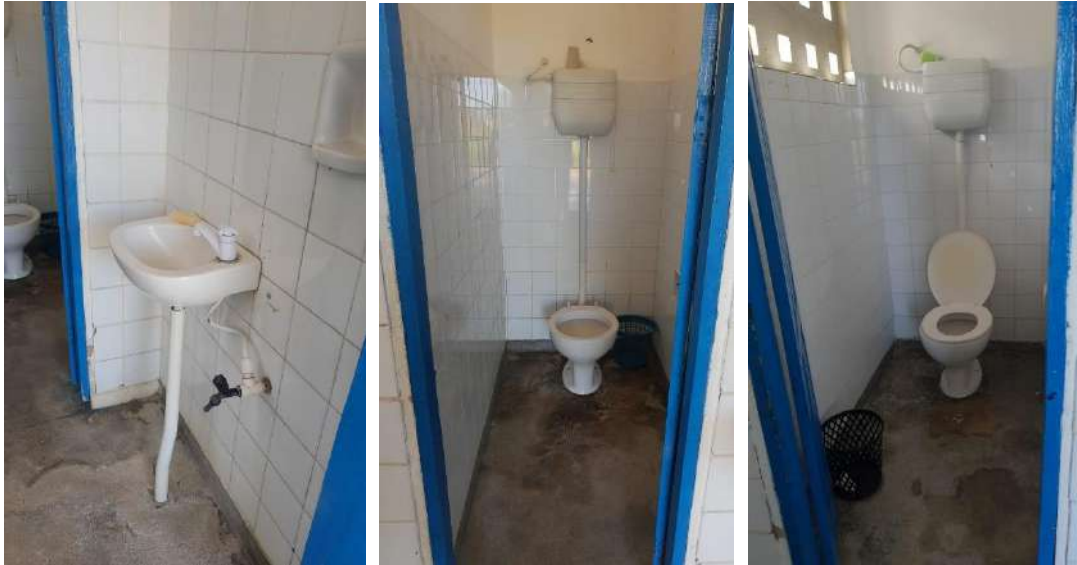
Fotos 9, 10 e 11 – Banheiros.
