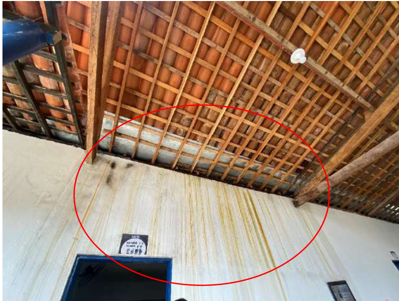
Foto 15 – Calha danificada.
