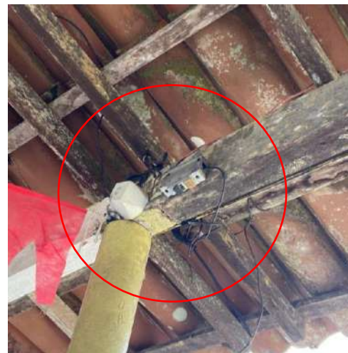
Fotos 6 e 7 – Instalação elétrica exposta.
