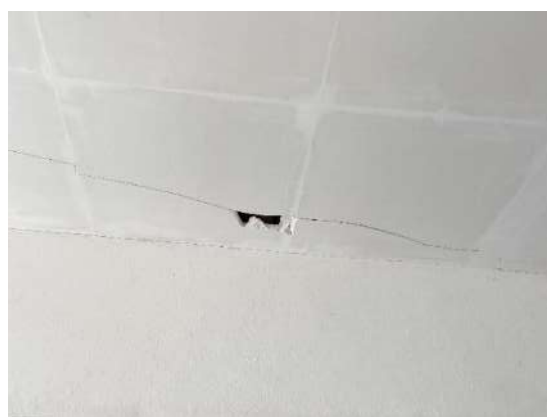
Foto 10 – Forro de gesso.
