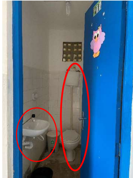
Fotos 10 e 11 – Banheiros.
