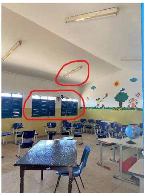
Foto 16 – Sala de aula.
