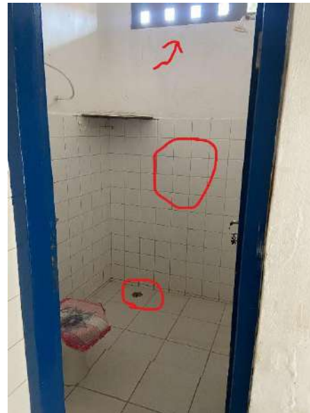
Fotos 4 e 5 – Banheiros.
