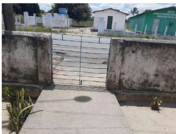
Foto 3 – Grade de entrada.
