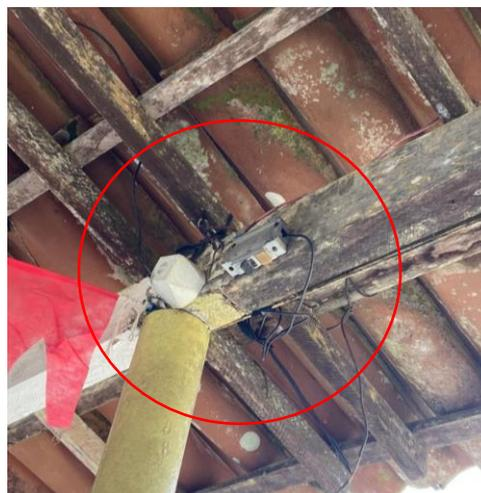
Fotos 6 e 7 – Instalação elétrica exposta.
