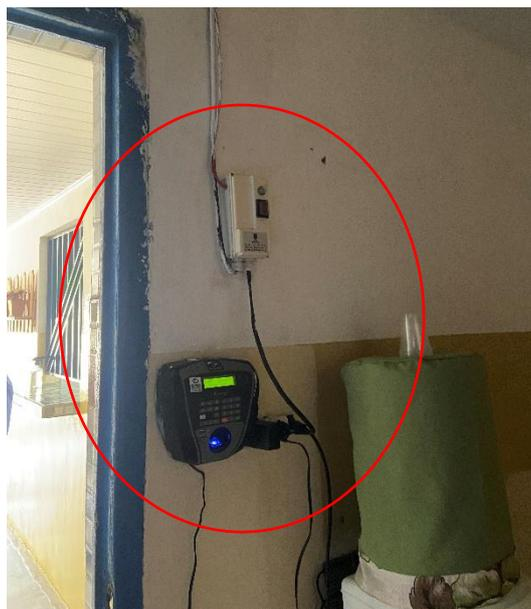
Foto 14 – Pontos de tomada insuficientes.
