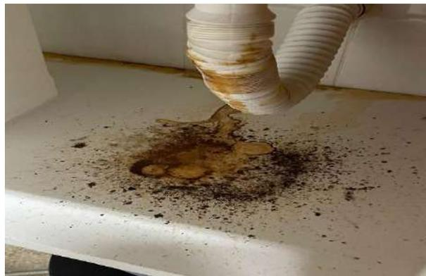
**Foto 05:** Revisão da rede hidráulica (troca de sifão, torneira, ralos, etc. Onde se fizer necessário)
