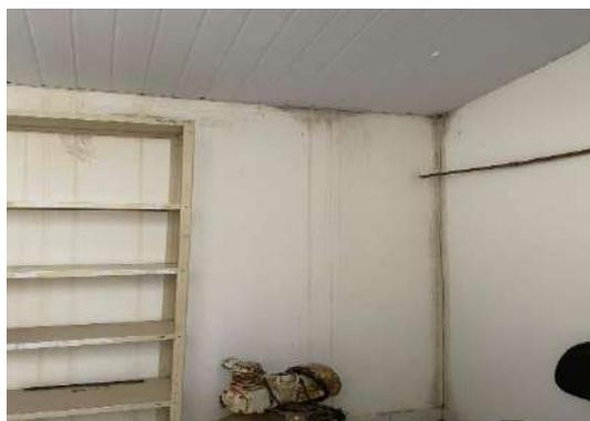
**Foto 03:** Vazamento (retelhamento)
