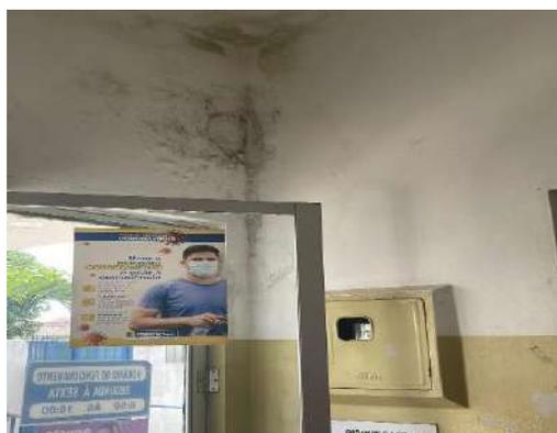
**Foto 02:** Pontos de Infiltração no teto (Recuperação de Coberta)
