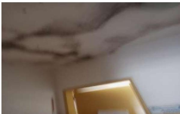
**Foto 03:** Infiltrações nas paredes
